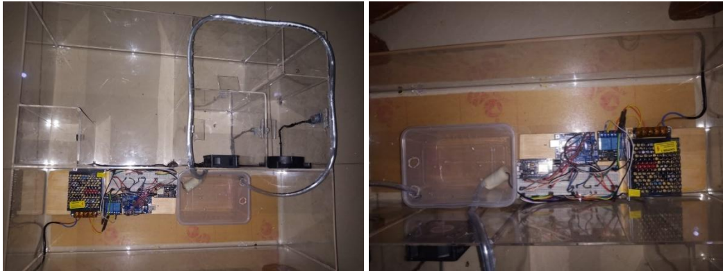
Gambar 6. Pemasangan alat pada prototipe rumah susun.
